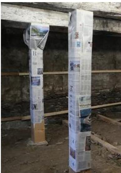
Was die Decke des kleinen Stalls S-W anbetrifft wurde beschlossen diese nach traditioneller Art zu „wiissgla“ (Weisskalk - Wasser-Mischung) genau so wie es früher in den meisten Ställen der Fall war. Vor dem „wiissgla“ mussten die Stützen, Lampen und vieles mehr mit Zeitungspapier & Klebeband abgedeckt werden. Die Balken & Deckebretter mussten von Hand mit Hilfe Drahtbürste, Schraubenzieher, Staubsauger etc. zuerst vom Dreck befreit werden.
