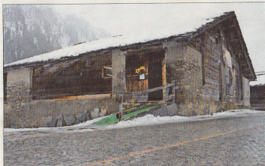
Der Bünlastall oder auch «die alte Dame», wie Stiftungsratspräsident Jean-François Tschopp das historische Gebäude liebevoll nennt. Bilder Loredana Pianegonda
